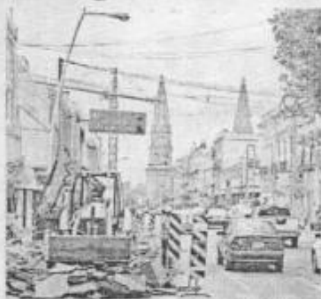
Al mediodía, los trabajadores que realizan obra en la lateral de Avenida Hidalgo, donde se ampliará el túnel, sí trabajan.
