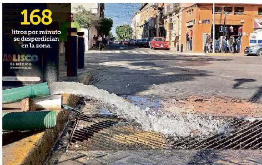
La manguera sale de las obras subterráneas para construir el túnel de la Línea 3.
