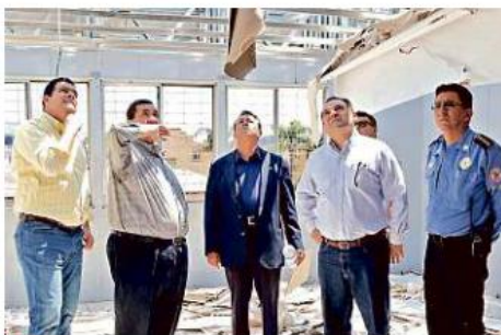
Francisco Ayón, titular de la SEJ (segundo de izq. a der.), acudió en junio a visitar la Secundaria 172 colapsada.
