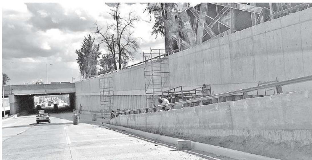
Aunque ya se desahogó en gran parte la vialidad en la zona, aún faltan obras necesarias como rampas. ESPECIAL
