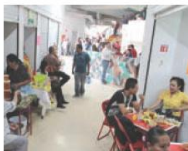
Hay quejas de goteras y otras fallas
