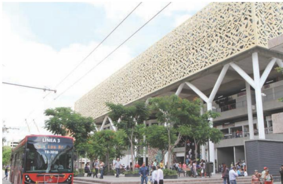
FALLAS. Los motivos para otorgar el aumento son por las pérdidas financieras que tienen al no poder terminar el último piso del estacionamiento
