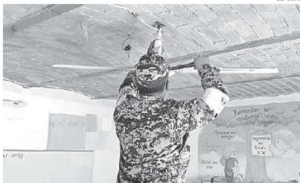
Los efectivos hicieron reparaciones en escuelas
