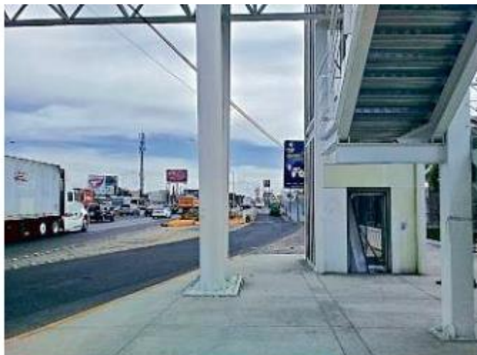
Este puente incluyente por la Colonia El Campanario costó 8 millones de pesos y se entregó en octubre de 2018.
