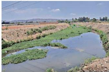
■ Así se ve desde Carretera a Chapala la Presa El Órgano; a los lados del Arroyo de En Medio se nota cómo ya fue aplanada la tierra con la que se relleno el terreno.
