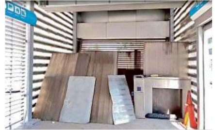
Una de las entradas a la Estación Niños Héroes del Macrobus está cerrada y con obstáculos arrumbados.
