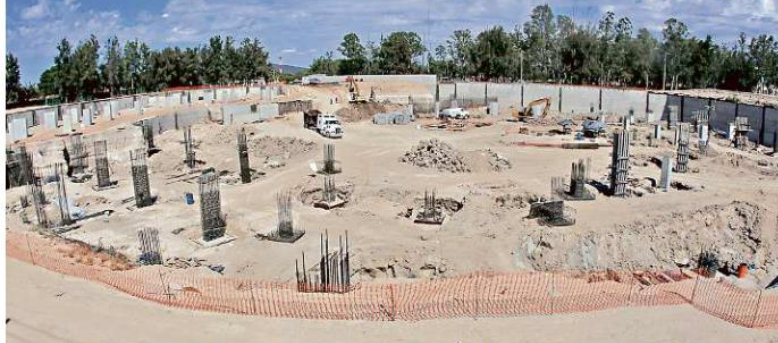
La empresa Súper Espectáculos SA de CV se encuentra terminando la cimentación de lo que será la Arena Guadalajara.
