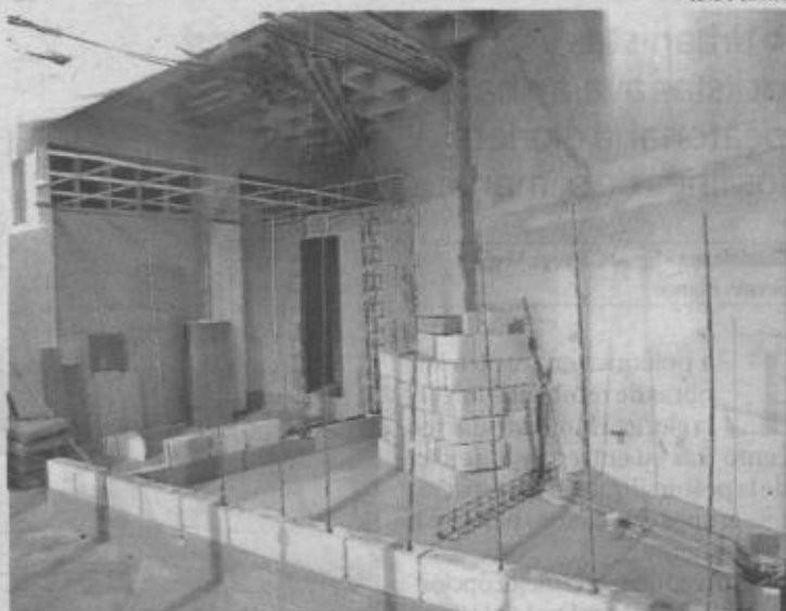
Tabiques de concreto se usaron para adecuar el espacio para el casino
