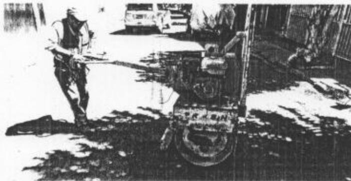
Para que funcione, la compactadora necesita gasolina, la cual extraen del camión que lleva la mezcla.
