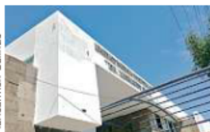
■ Esta es la Unidad Médica Leonardo Oliva donde habría realizado obras de rehabilitación en 2016.
