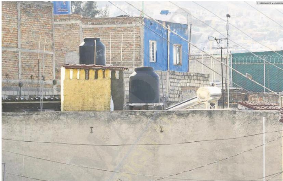
AHORRO. El Infonavit ofrece créditos para equipar viviendas nuevas o usadas con tecnologías ahorradoras, como paneles solares que reducen el consumo de electricidad.
