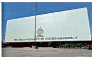
■ También se le pagó por el remozamiento del edificio de Obras Públicas de GDL, en la Calle Hospital 50-Z.
