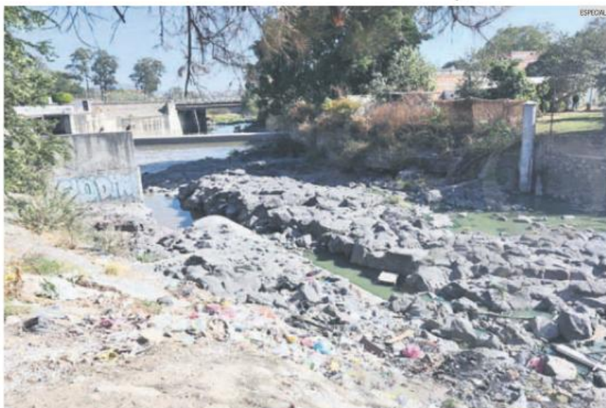
BASURA. Con colectores sanitarios buscan disminuir la contaminación y los malos olores del Canal de Atemajac.
