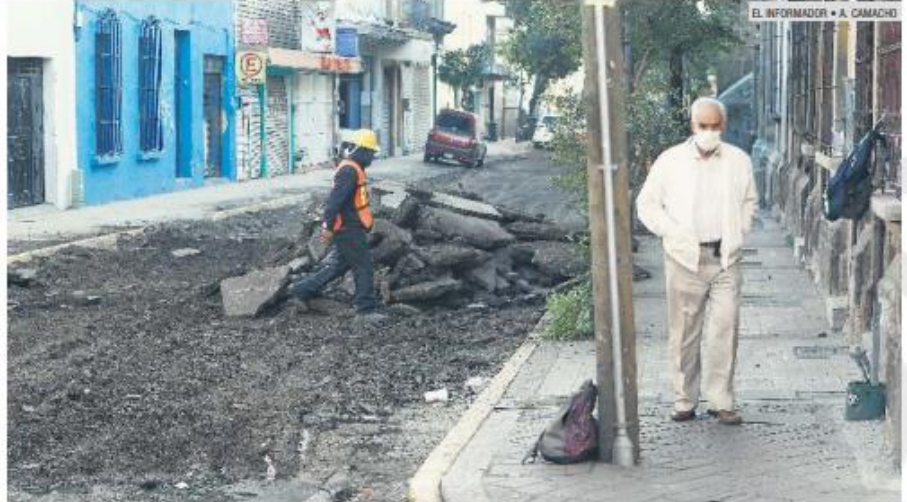
TRABAJOS. El avance de las labores en la vialidad es de 56 por ciento en la primera etapa.
