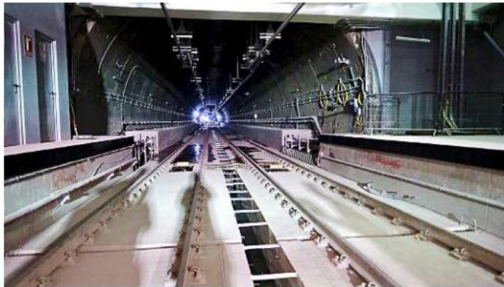
■ Se verificó el avance de la obra desde la estación La Normal hasta El Santuario.
