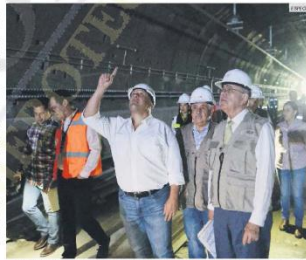
RECORRIDO. Enrique Alfaro, gobernador de Jalisco y Javier Jiménez Espriú, secretario de Comunicaciones y Transportes, recorrieron ayer la obra de la L3.
