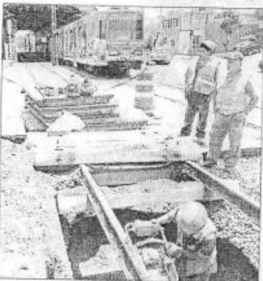
La suspensión del servicio de la Línea 1 del Tren Eléctrico se debió a una solución que apareció cerca de la Estación Urdaneta ■ Foto: cortesía Sitrac
