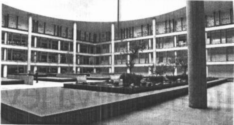
¿PARA CUÁNDO? El Poder Judicial de Jalisco inició la mudanza para la Ciudad Judicial, pese a que el tercer piso no está terminado y se convirtió en el sitio para guardar materiales.
