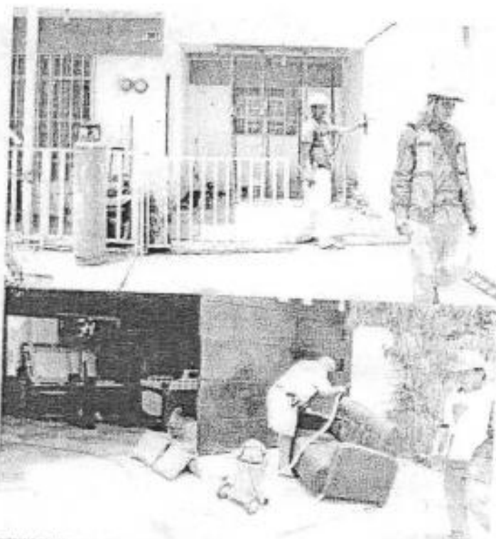
CONSECUENCIAS. Es necesario apuntalar ocho viviendas que resultaron afectadas por la inundación.
