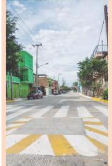
**RENOVACIÓN.** Se colocó concreto hidráulico y se cambiaron banquetas, entre otros arreglos.
