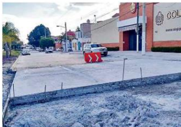
■ En la zona de obras de Avenidas Tchaikovski hay cinco planteles escolares que se ven afectados por la restricción.
