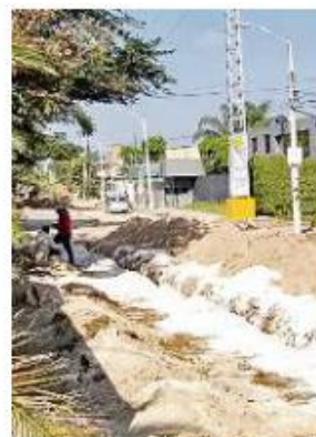
■ Vecinos ven pocos trabajadores en la repavimentación de Volcán del Colli-Clouthier.
