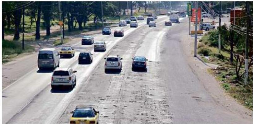
El sentido norte-sur de Carretera a Chapala será intervenido en una segunda fase. Aquí se muestra el deterioro de la carpeta asfáltica en la subida de El Tapatio.
