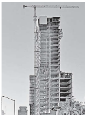
Sigue construcción de edificios
