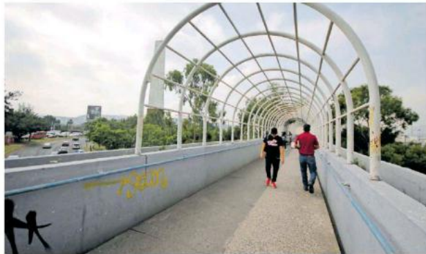
El puente está ubicado en el cruce de Inglaterra y Mariano Otero, en la zona conocida como Pueblo Quieto, en Guadalajara. FOTO: FRANCISCO RODRIGUEZ
