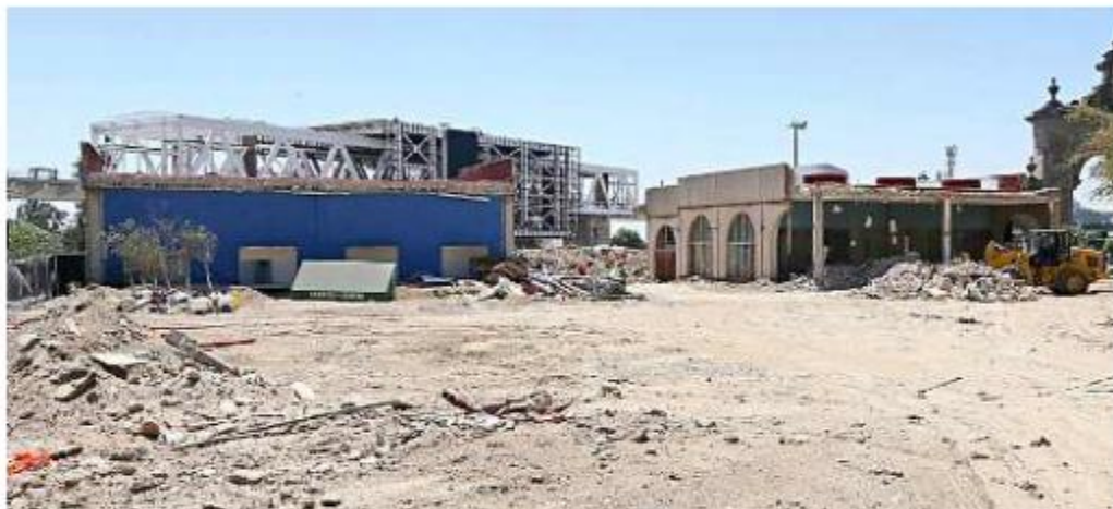
■ El Municipio de Zapopan demolió la mayoría de los locales ubicados en la ex plaza Los Arcos.
