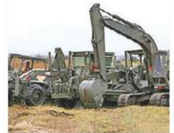
Inician la obra. A. PÉREZ
