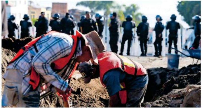
Los trabajos de la línea de conducción inician en el cruce de la carretera libre a Zapotlanejo y carretera a El Salto. FOTO: CORTESÍA / GOBIERNO DEL ESTADO
