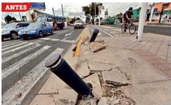
■ La ciclovía de Av. Santa Margarita fue construida por el Ayuntamiento de Zapopan y se entregó en 2014.
