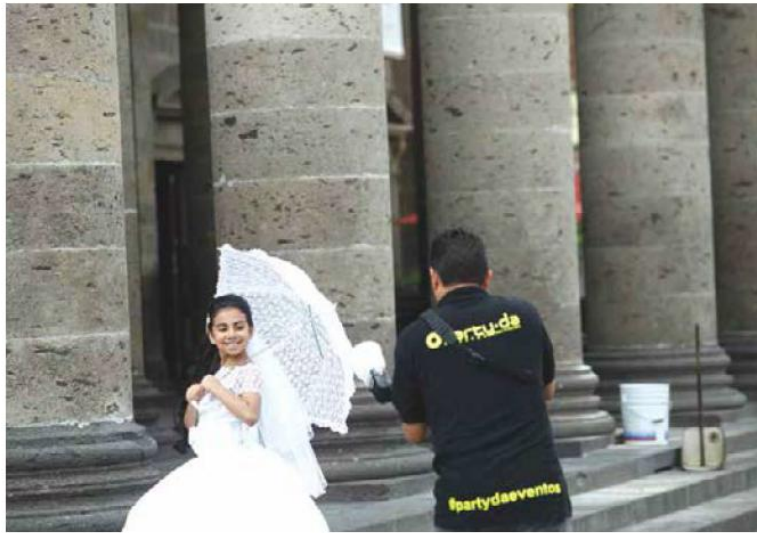
LIMPIEZA. Las columnas del recinto cultural ya fueron intervenidas.
