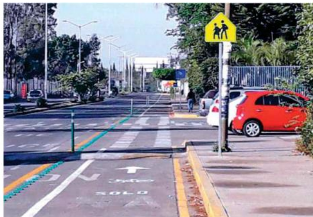
La vía estará terminada en tres meses.
