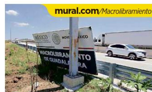
El Macrolibramiento presenta señalamientos tanto informativos como restrictivos derribados, entre otros daños.
