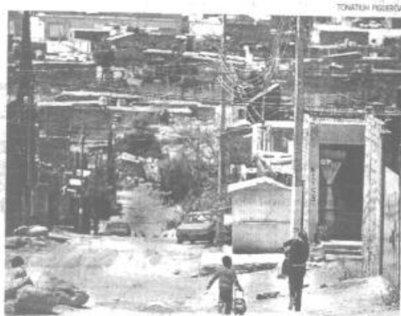
Ex contralor autorizó los pagos por obras mal hechas en colonias sin agua
