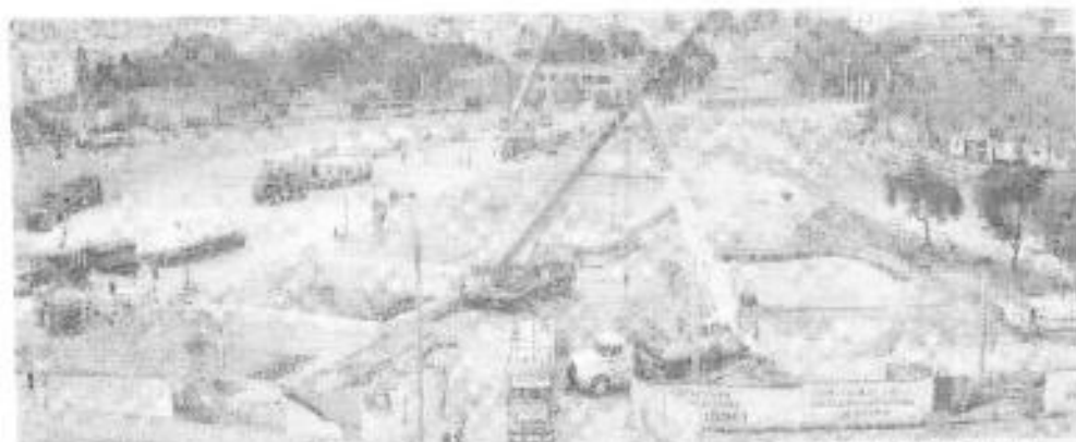
En la Glorietta de La Normal se almacenan las piezas de la maquinaria para abrir el túnel de la L3.
