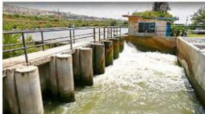
**4** En el kilómetro 26, el agua deja de ser bombeada y se conduce con gravedad hasta llegar a un Tanque de Entrega que la manda a dos potabilizadoras.
