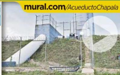
**3** Ante paros por cortes de energía en los equipos de bombeo están los Tanques Unidireccionales 1 y 2 que controlan el "golpe de ariete" dentro del ducto.
