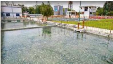
**5** Una potabilizadora es la 1 de Miravalle (PPI), donde el agua recibe cloro y químicos como sulfato de aluminio; llega al clarificador y a filtros.
