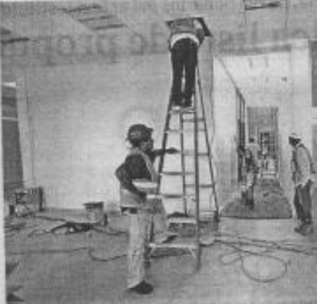
En el inmueble todavía se realizan labores de carpintería y pintura
