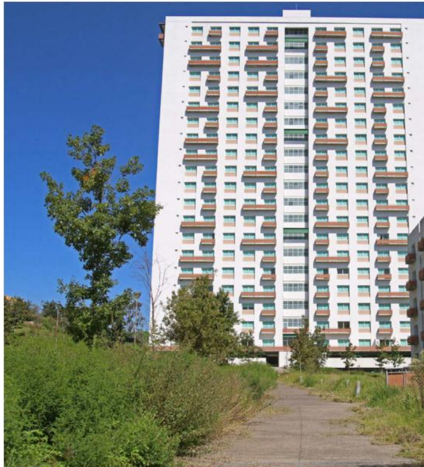
Deben respetarse los espacios que no han sido construidos. FERNANDO CARRANZA
