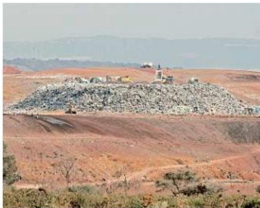
La empresa Caabsa Eagle trabaja en la ampliación de 308 mil 160 metros cuadrados del vertedero Los Laureles.
