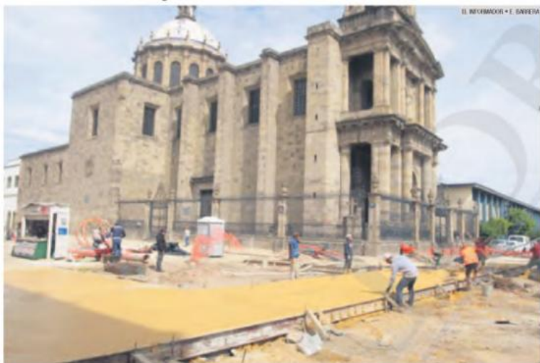
CONCRETO. Trabajadores dan forma al cruce de Alcalde y Reforma.
