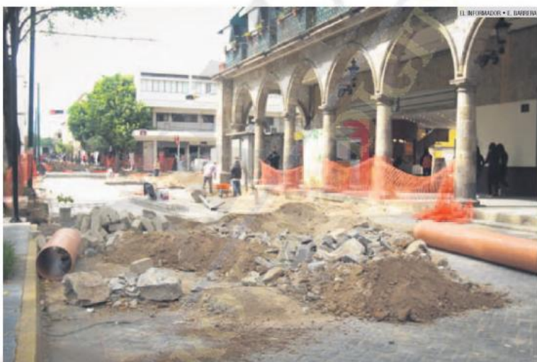
ESCOMBRO. En Independencia y Alcalde aún se trabaja en la losa de la calle.
