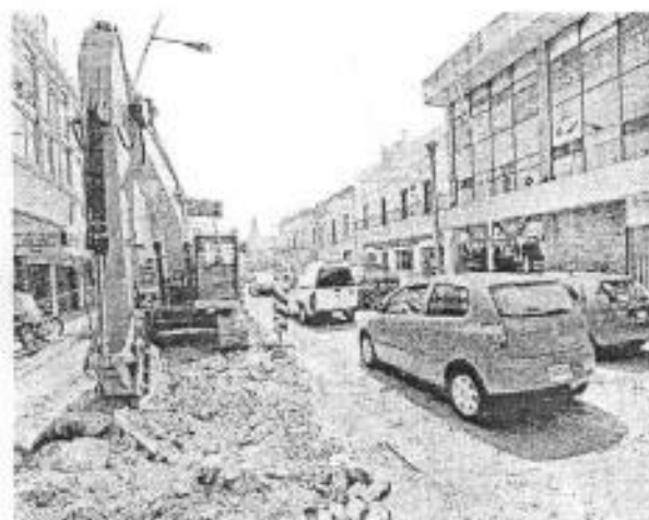
Sobre una lateral Avenida Hidalgo se realizan los trabajos preparativos para la ampliación del túnel. Ayer descansaron.
