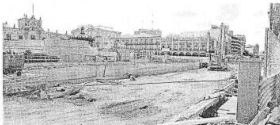
En Avenida Alcalde-16 de Septiembre, entre Hidalgo y Juárez, no había movimiento de personal ni de maquinaria. Ahí se construye la estación Catedral para la Línea 3 del Tren Ligero.
