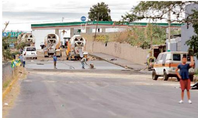
■ En un recorrido ayer, se constató la presencia de maquinaria y trabajadores en la zona. Alrededor no hay lonas que adviertan sobre los trabajos o el cierre.
